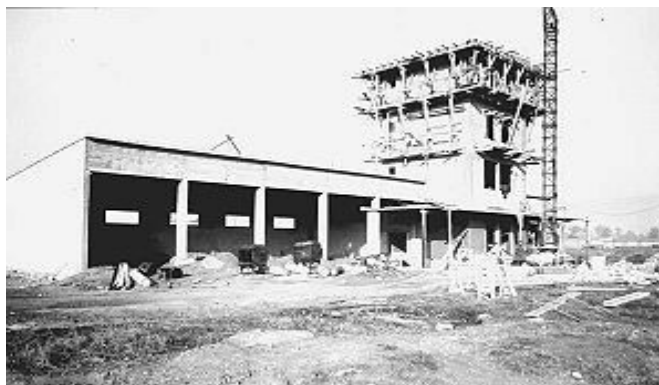
construction de la tour de contrôle
